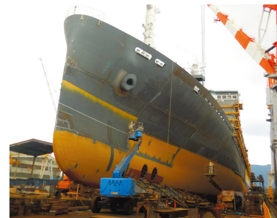
船台にのり建造中のおがさわら丸
